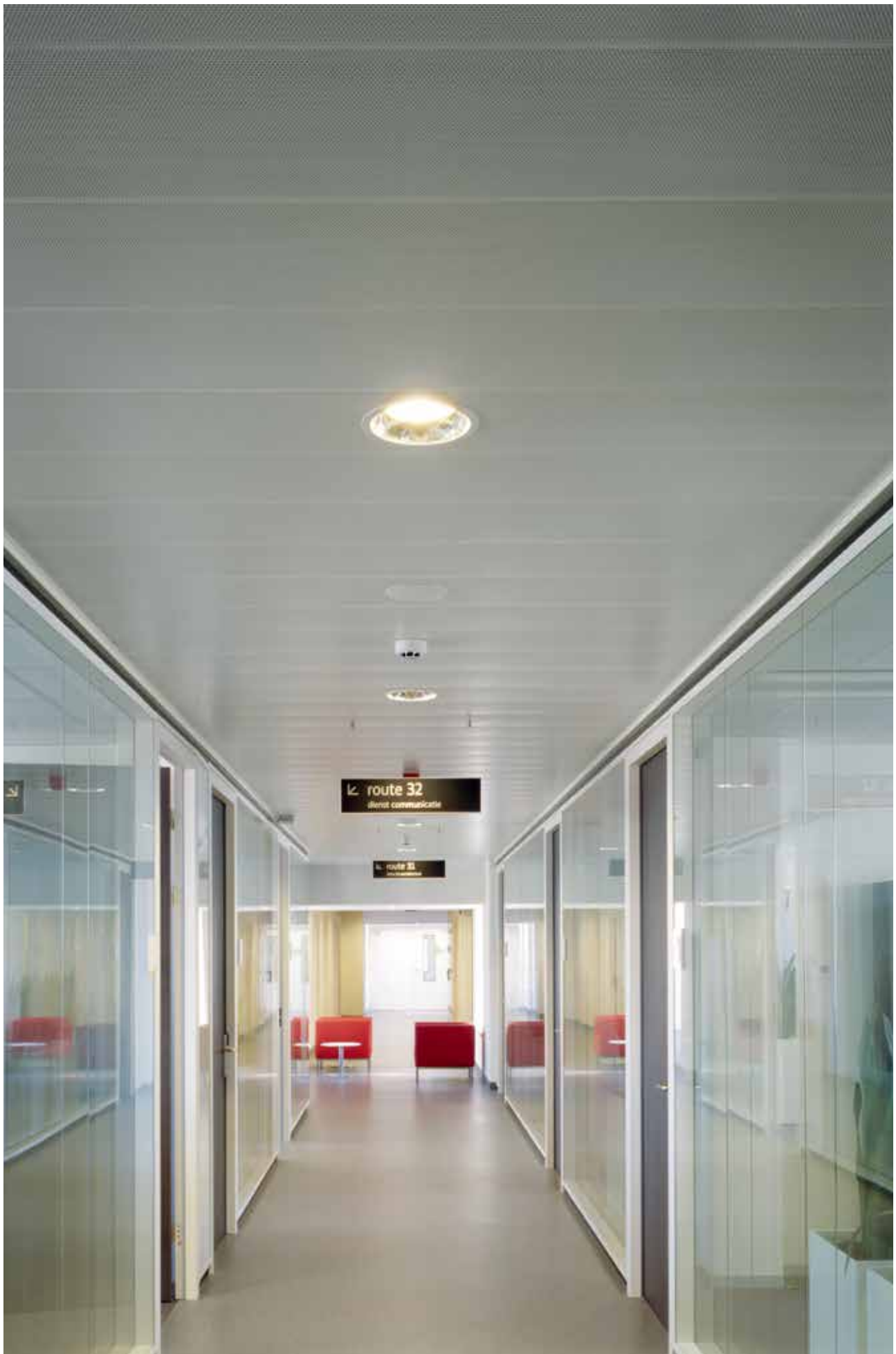
Project: Sint-Vincentius GZA Ziekenhuizen, Berchem, Belgium - Product: Wide Panel 300C (Lay-On) - Architect: Architectenbureau De Vloed, Heusden-Destelbergen
